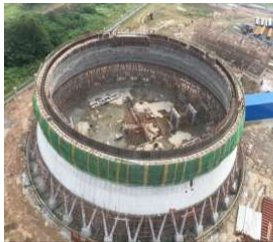
冷却塔筒壁施工
