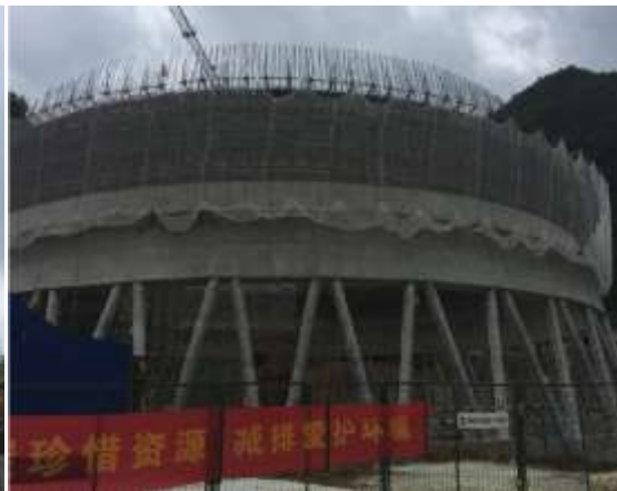
冷却塔環梁施工
