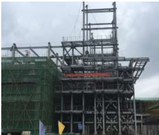
鍋爐鋼架吊裝
