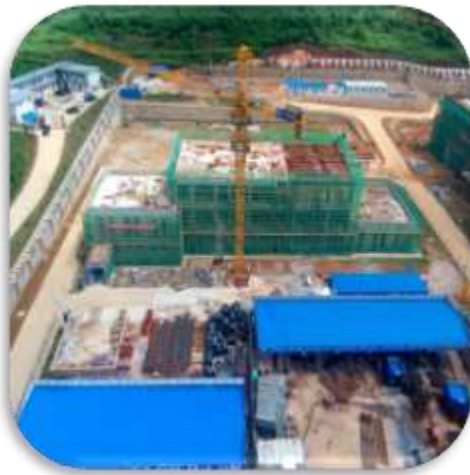
現場整體施工
