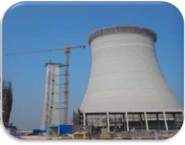
冷卻塔施工
