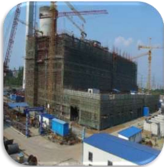
現場整體施工
