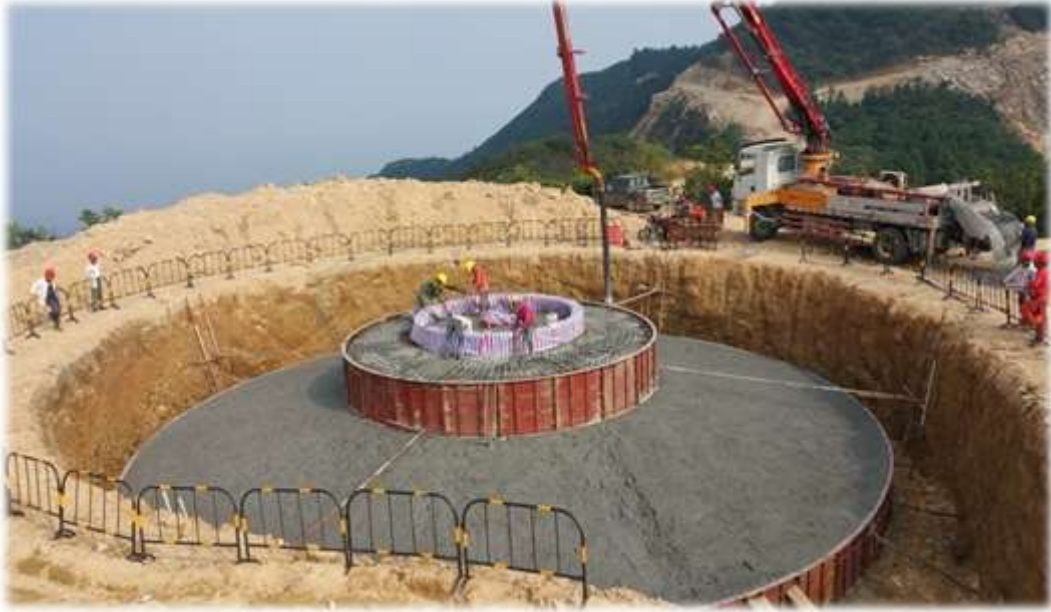
麻城風機基礎澆築
