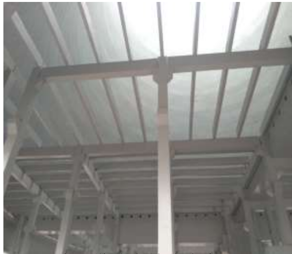
冷卻塔淋水構件防腐
