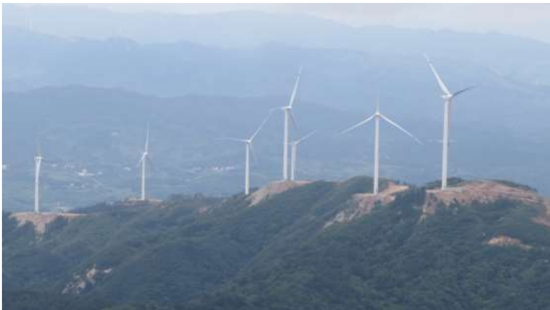
部分吊裝風機
