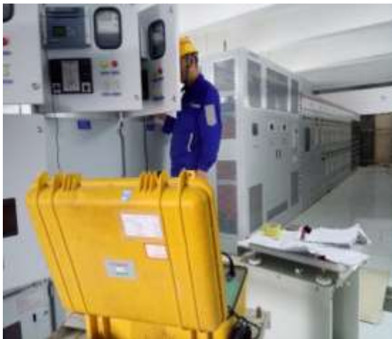
10KV 盤櫃做電氣試驗
