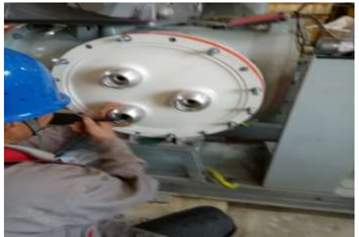
GIS 設備安裝
