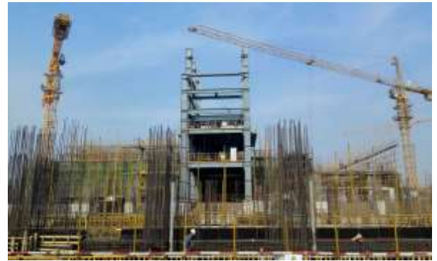
鍋爐鋼架吊裝
