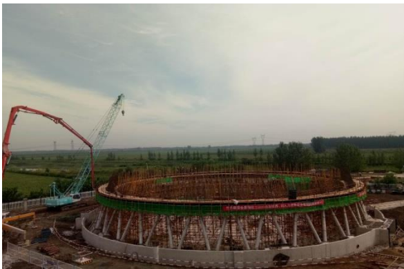
煙塔區域冷卻塔人字柱及環梁施工
