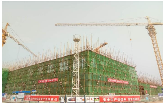
汽機房 17.96 米層結構施工
