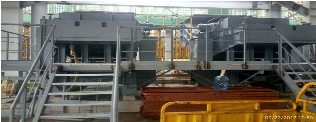
除渣機安裝完成
