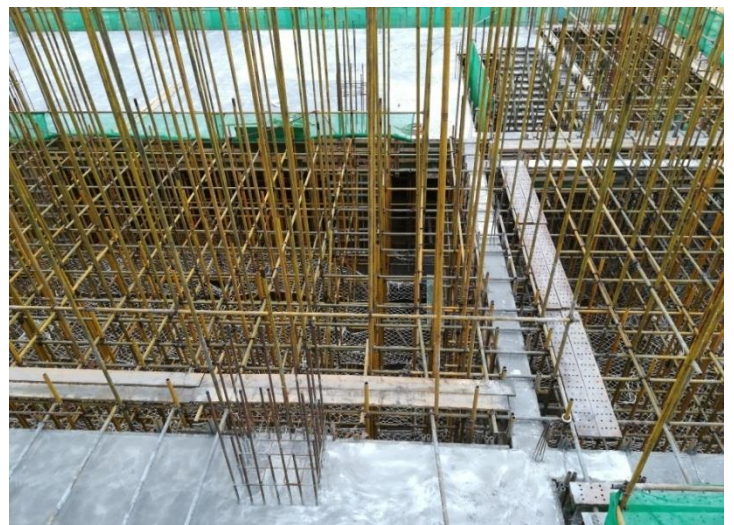
聯合車間結構施工
