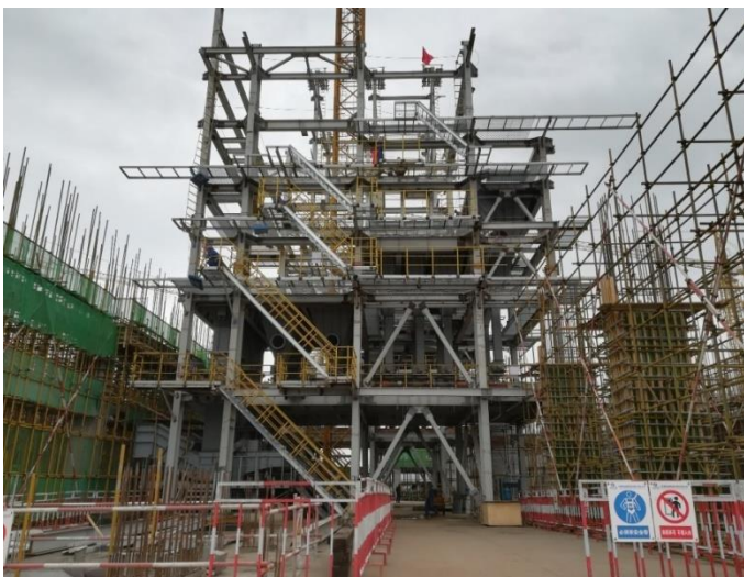
焚燒爐鋼架安裝
