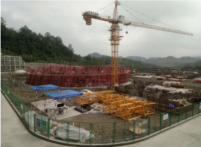
冷卻塔區域施工
