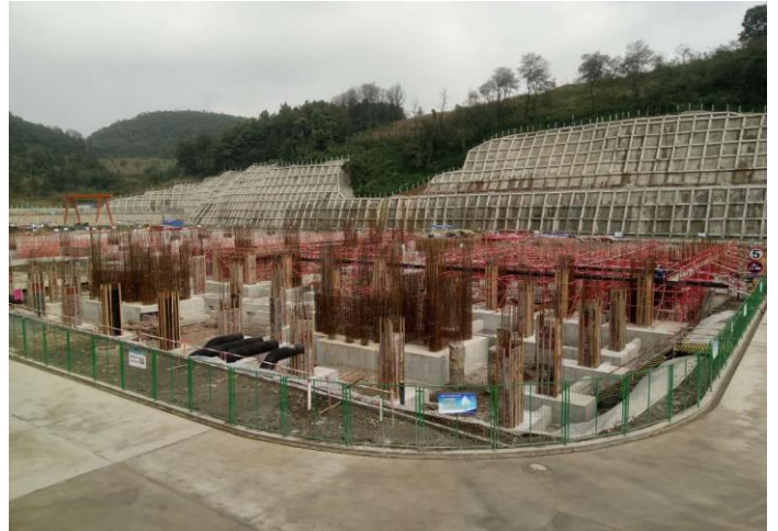
主廠房區域施工
