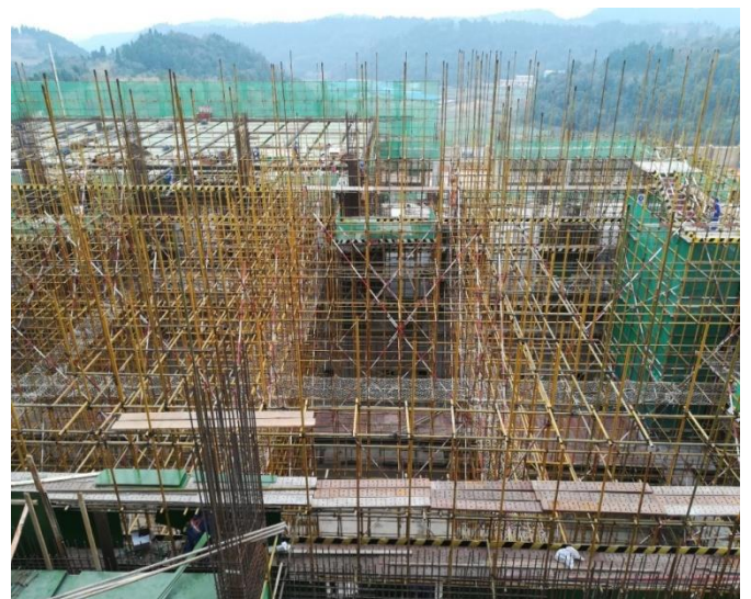
垃圾池結構施工
