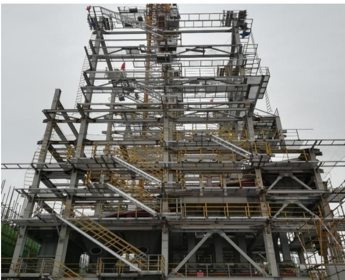
焚燒爐鋼架安裝
