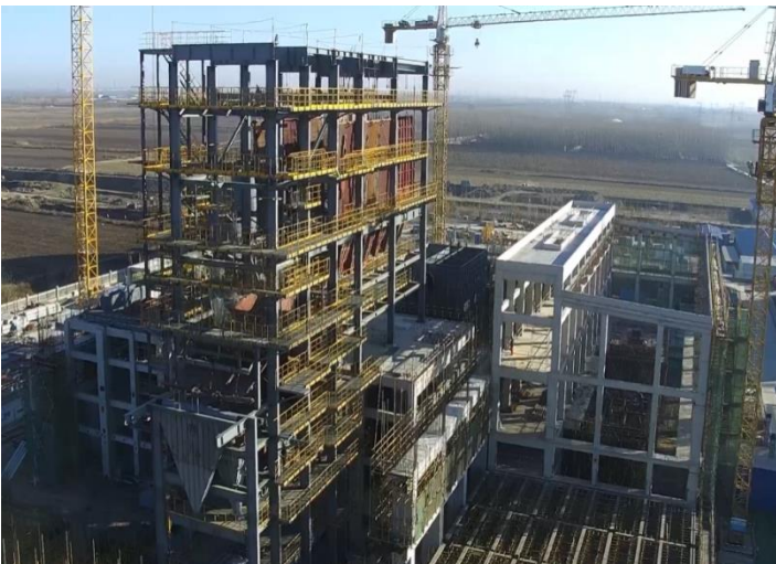
#1 鍋爐鋼架安裝
