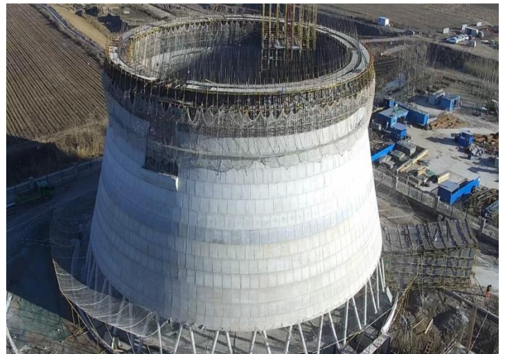
煙塔區域冷卻塔筒身施工
