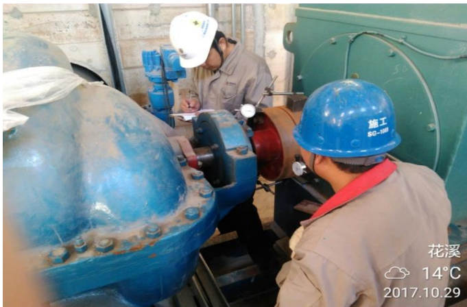
迴圈水泵聯軸器中心測量調整驗收完成
