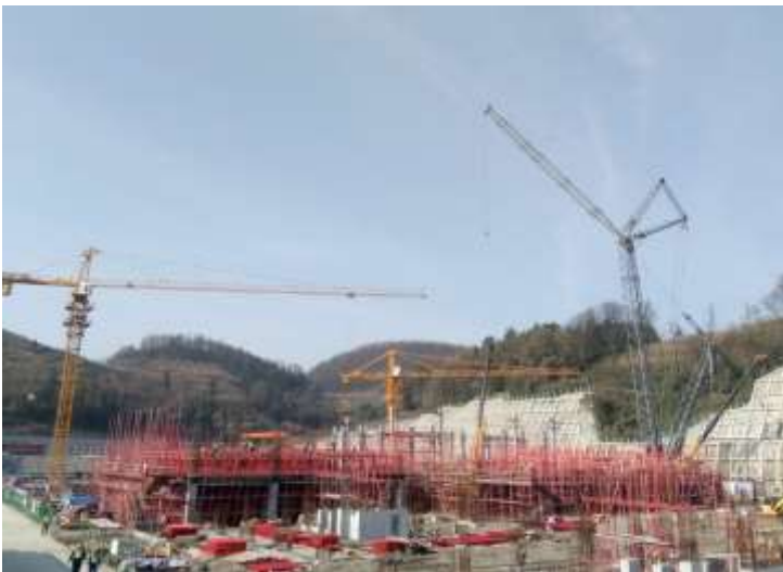
主廠房施工區域
