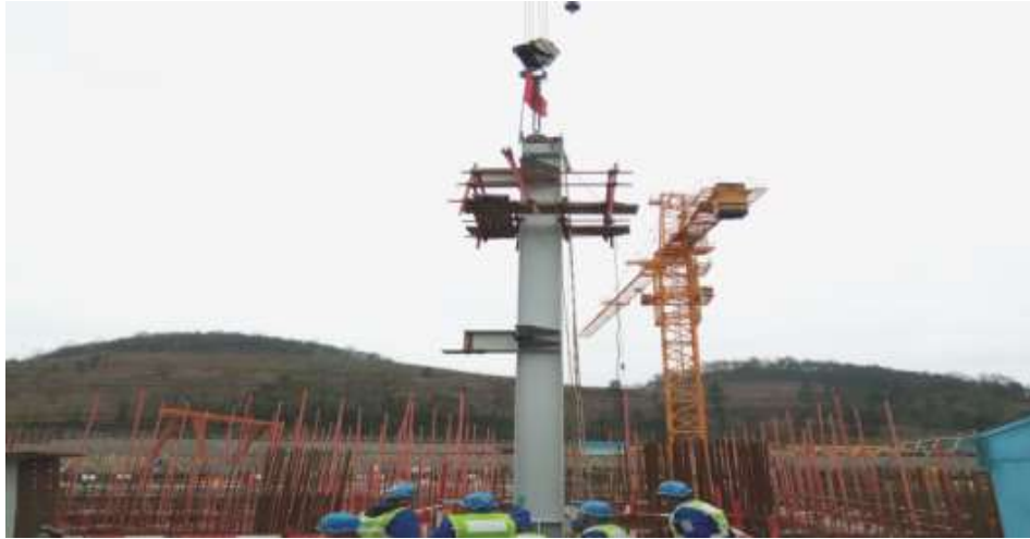
#2 鍋爐第一根鋼結構吊裝完成
