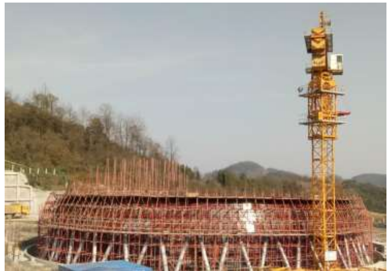
冷卻塔施工區域
