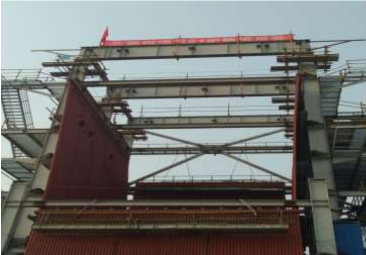
焚燒爐鋼架安裝
