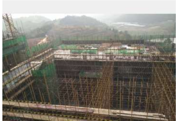
垃圾池結構施工
