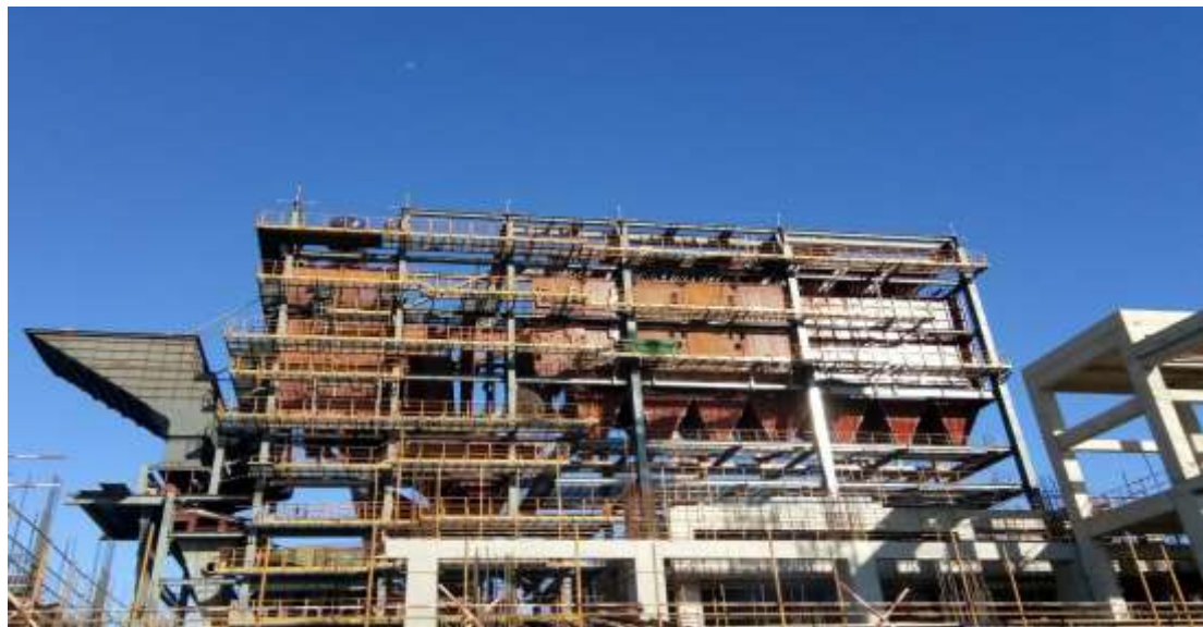
#1 鍋爐設備安裝
