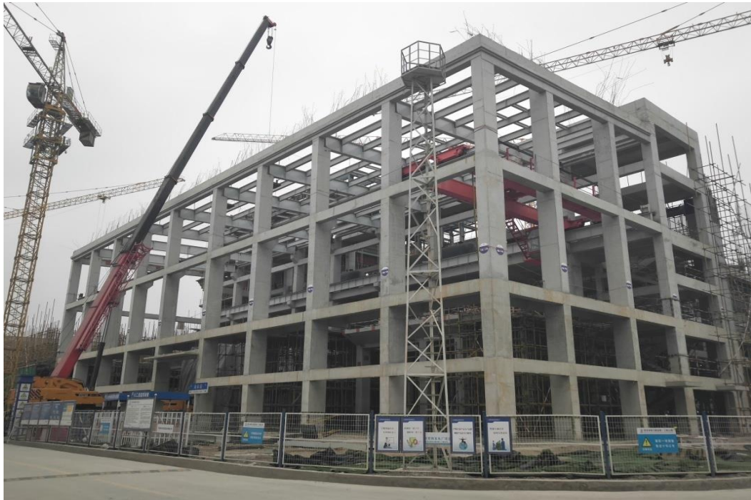
汽機房屋頂鋼架吊裝
