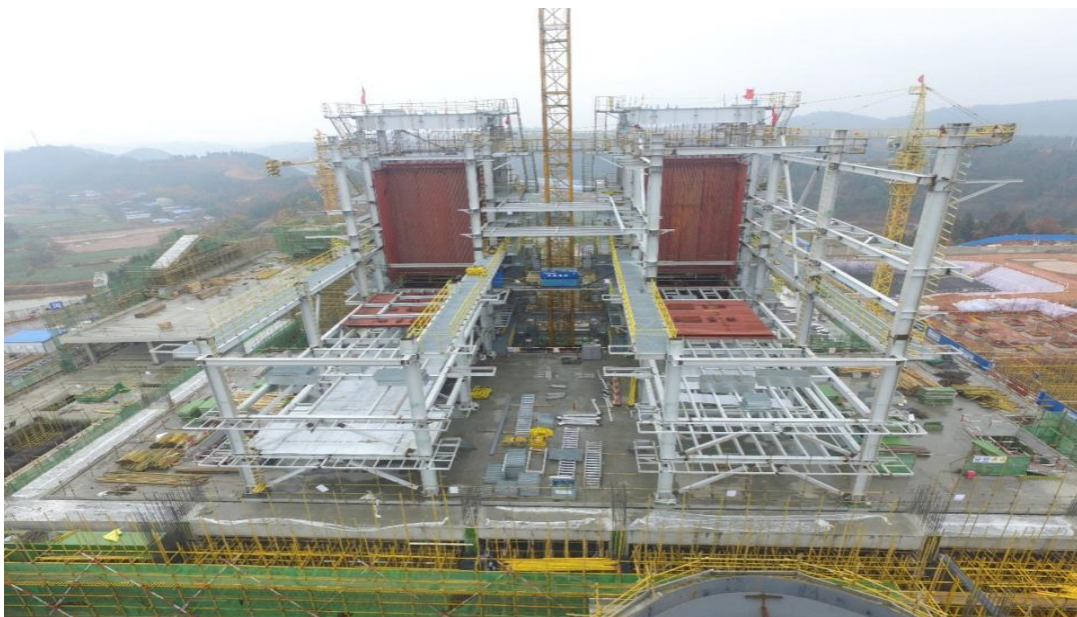
垃圾池結構施工
