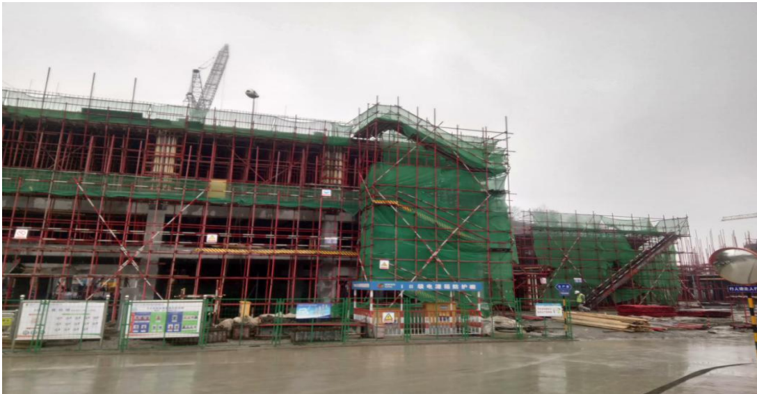
冷卻塔施工區域
