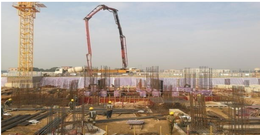
第一套機組汽機基座底板混凝土澆築
