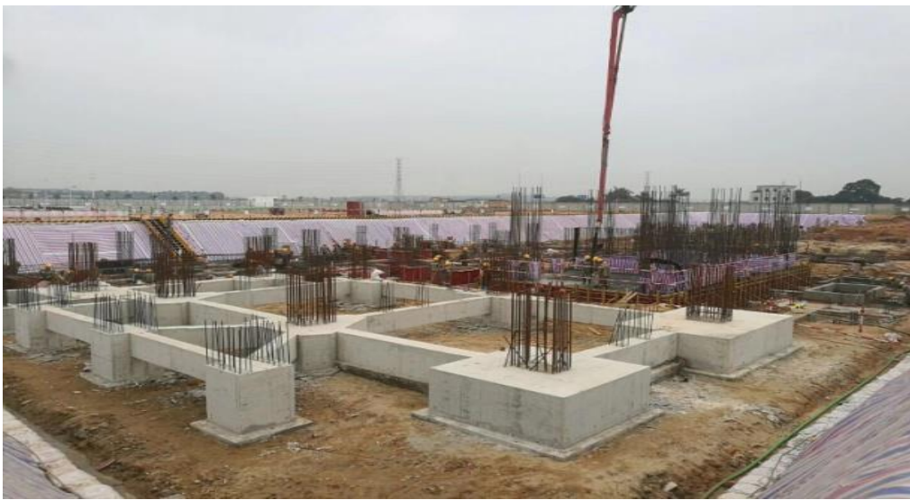
主廠房基礎施工
