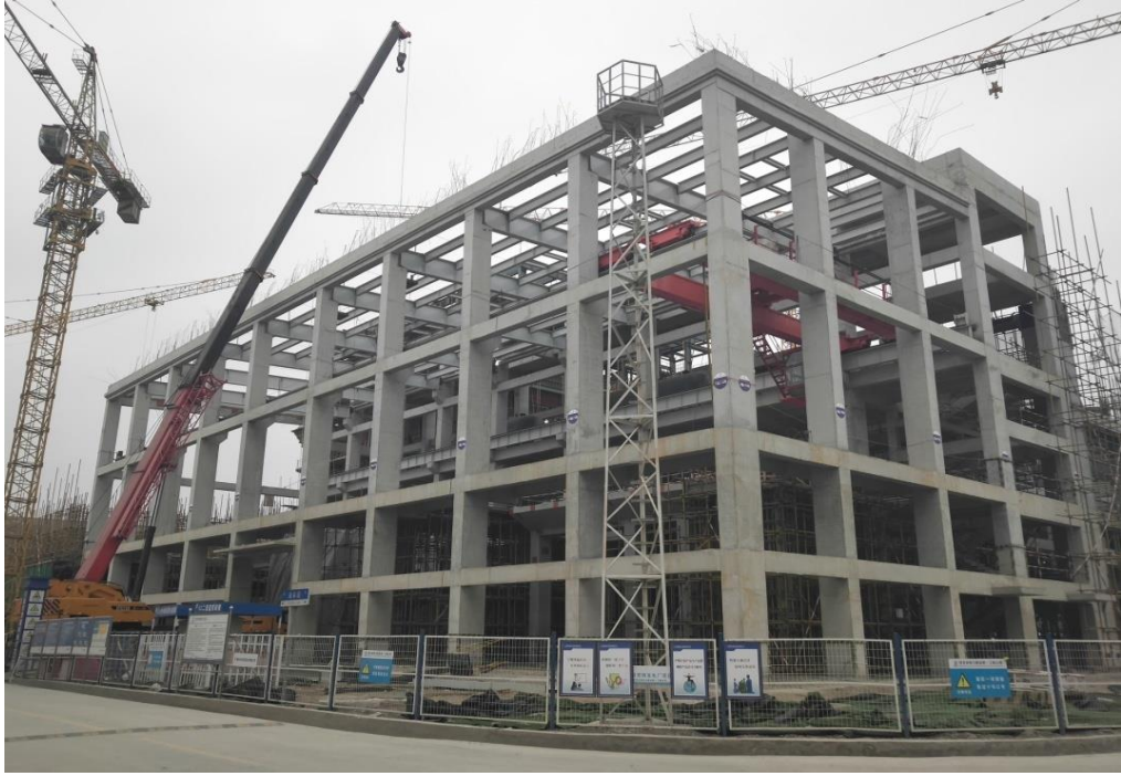
汽機房屋頂鋼架吊裝
