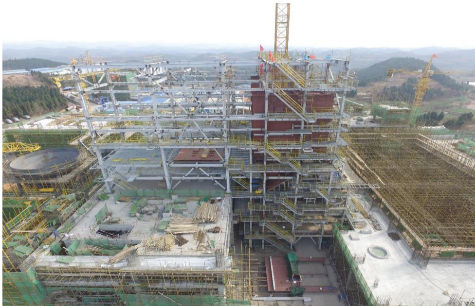
鍋爐鋼架安裝
