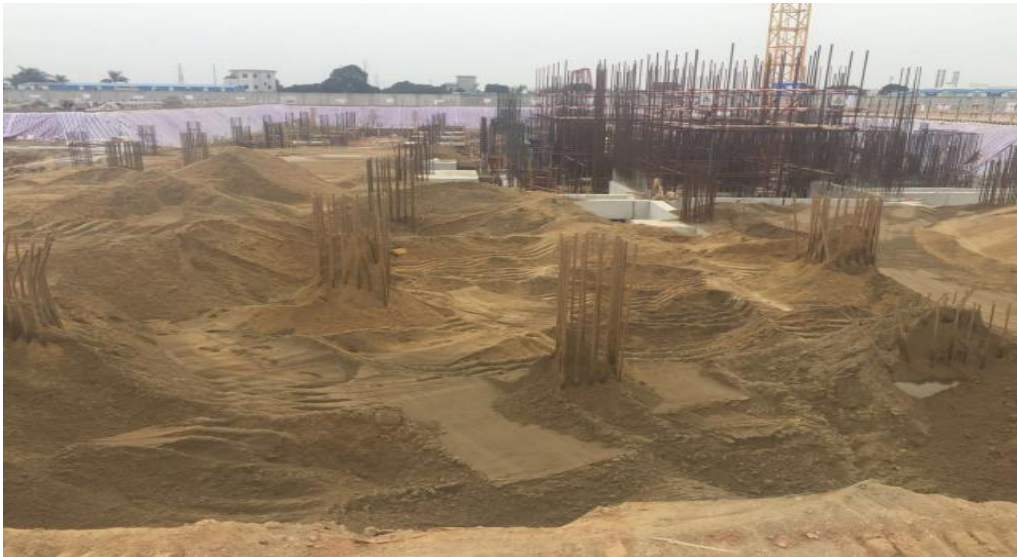
主廠房基礎施工
