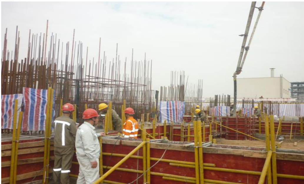
1# 主廠房迴圈水泵坑混凝土澆築施工
