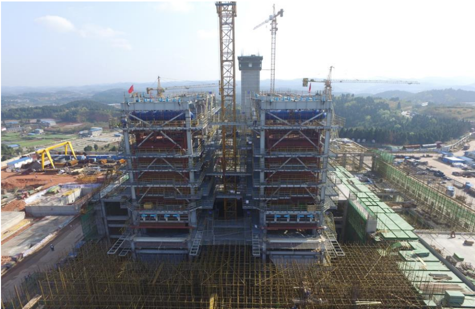
鍋爐鋼架安裝
