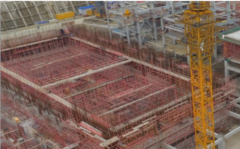
垃圾庫施工區域
