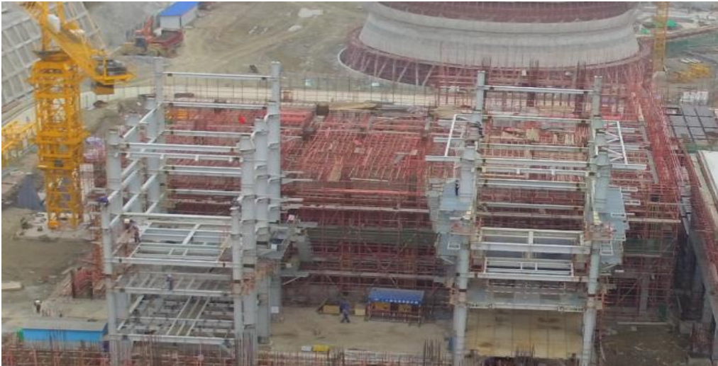
#1、#2 焚燒爐鋼架吊裝施工
