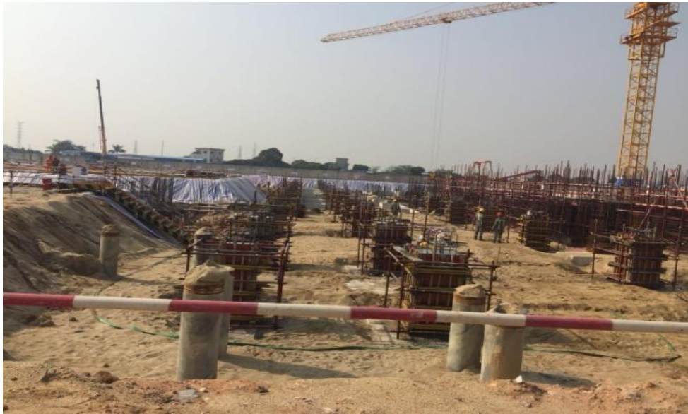
#1 主廠房基礎短柱施工
