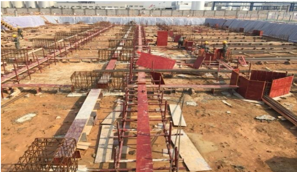
化水車間基礎施工
