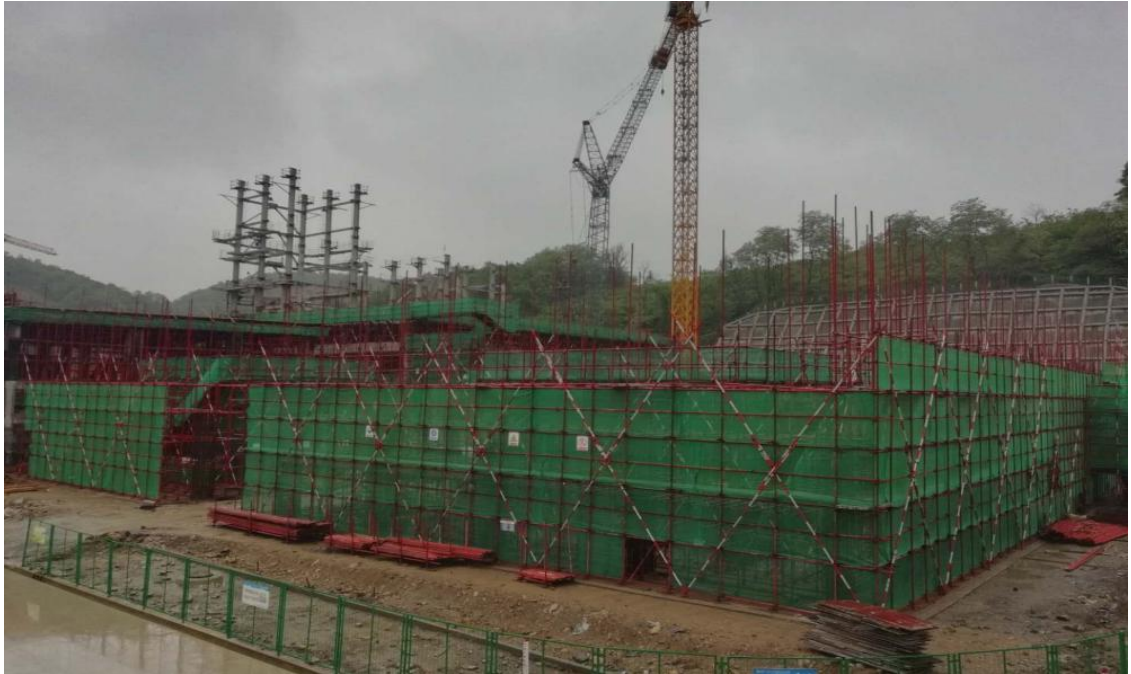
汽機房施工區域
