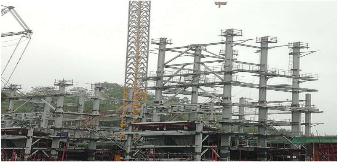
#1、#2 焚燒爐鋼架吊裝施工
