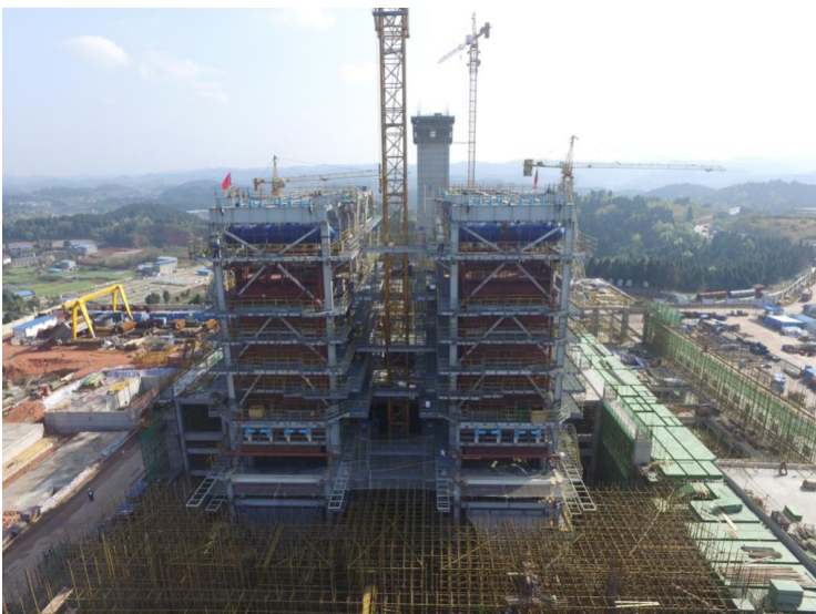
鍋爐鋼架安裝
