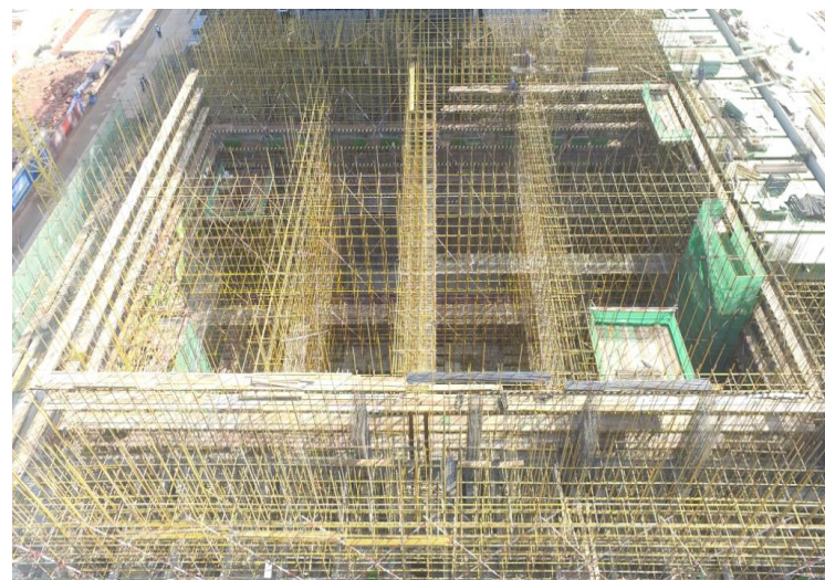
垃圾池結構施工
