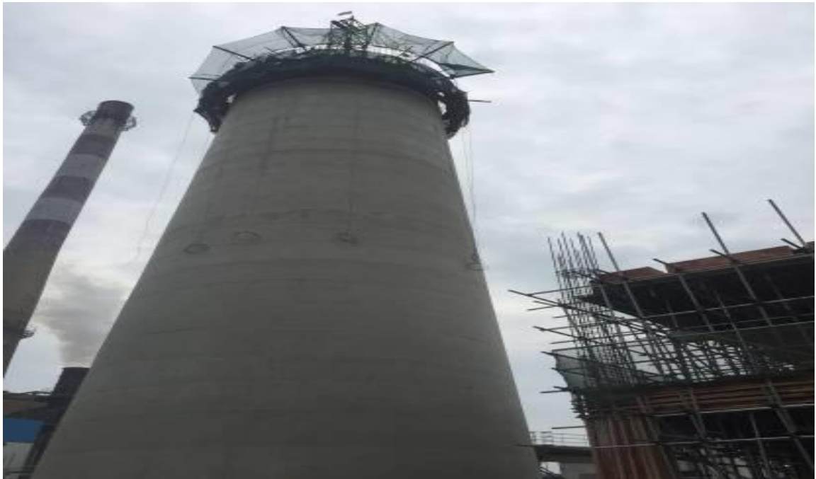
煙囪筒身 25 節澆築完成
