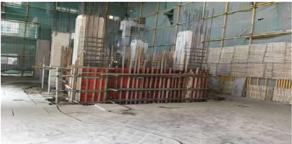
汽輪機基礎 1.77 米層澆築完成
