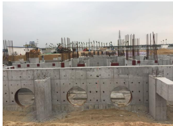
1#迴圈水坑施工完成
