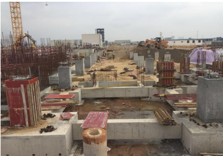
#2 主廠房基礎短柱施工完成
