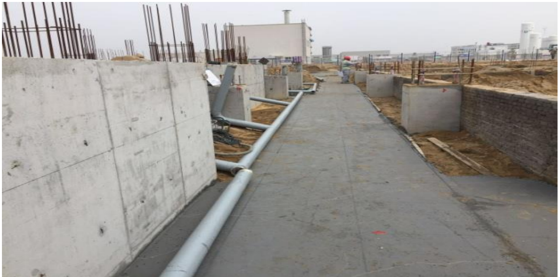
#1 主廠房零米以下施工
