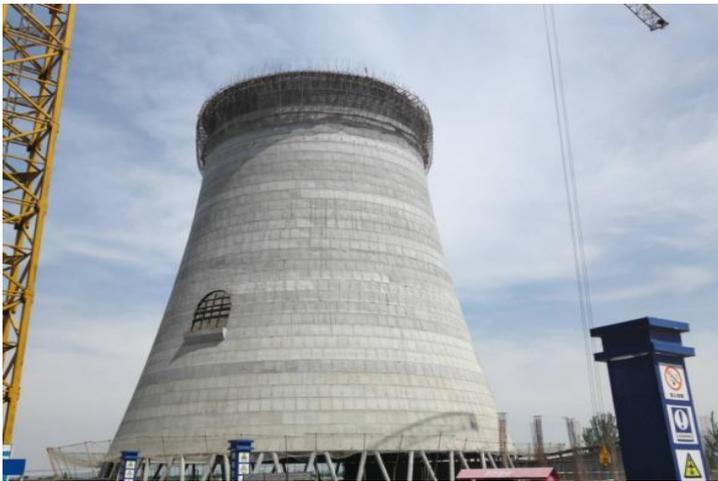
冷卻塔筒身 32 板澆築完成
