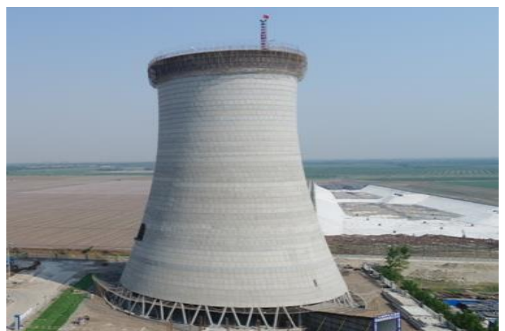
冷卻塔筒身到頂澆築完成
