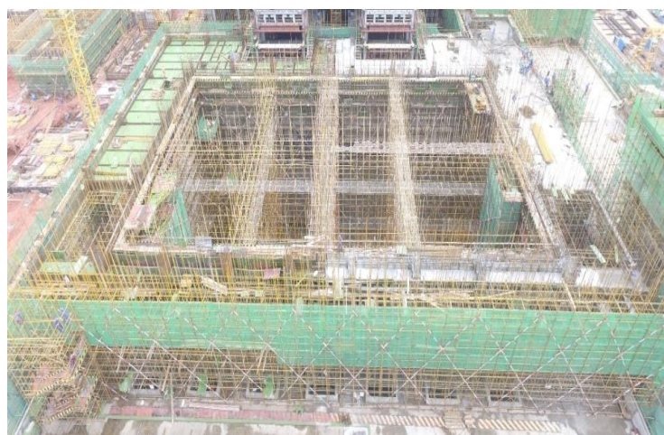
鍋爐鋼架安裝
