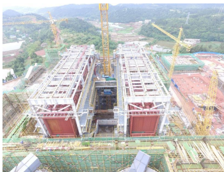
垃圾池結構施工
