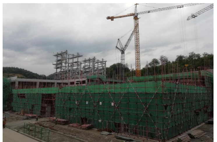
汽機房施工區域
