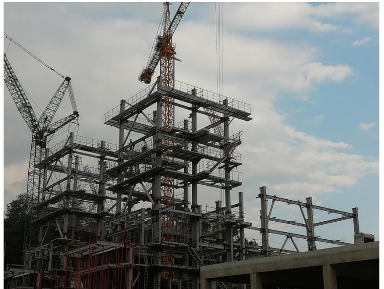
#1、#2 焚燒爐鋼架吊裝施工
