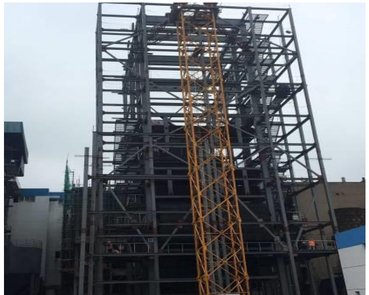
鍋爐鋼架吊裝
