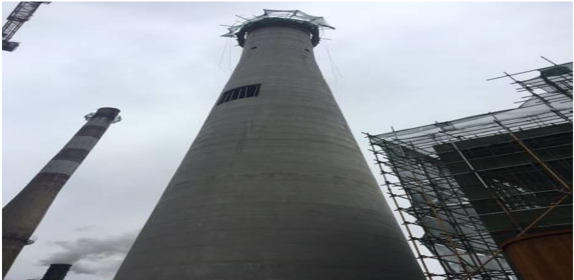
煙囪筒身 56 節澆築完成
