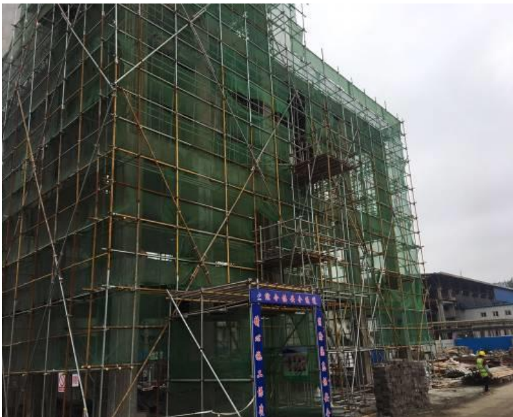
環保島脫硫綜合樓四層澆築完成
