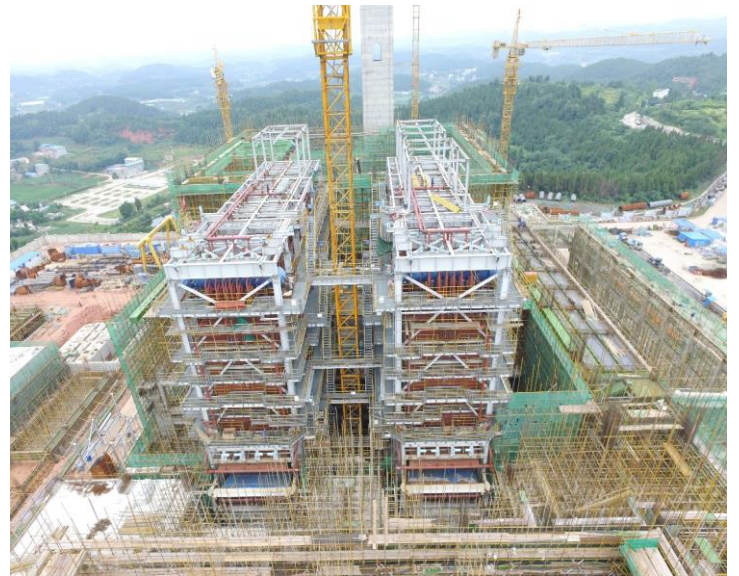
鍋爐鋼架安裝
