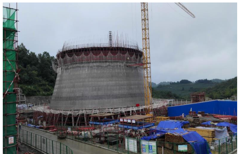
冷卻塔施工
