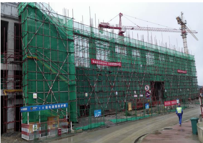
汽機房施工區域
