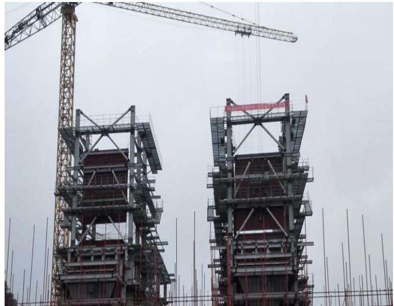
#1、#2 焚燒爐鋼架吊裝施工
