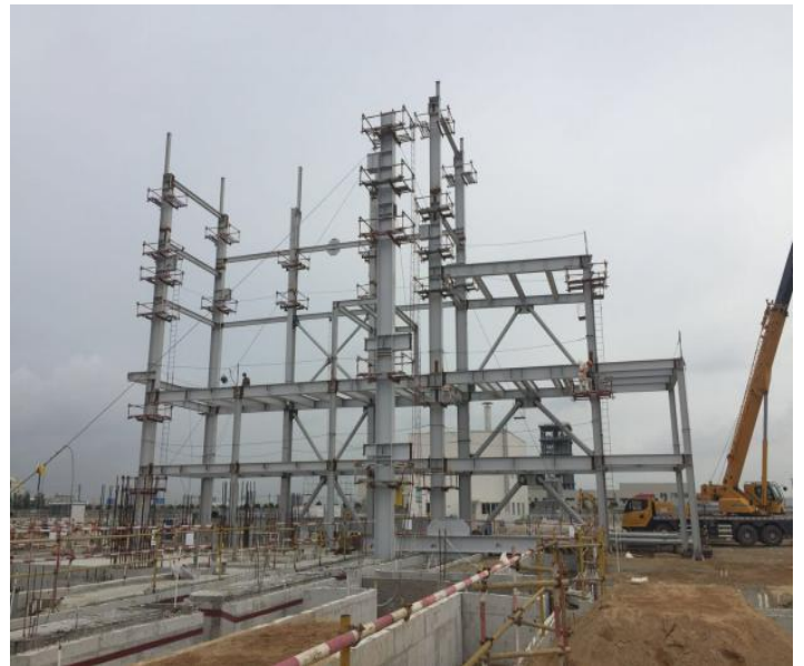
#1 主廠房鋼結構吊裝
