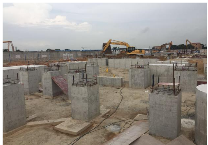
#2 鍋爐零米以下基礎施工完成
