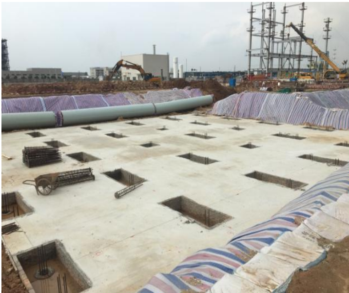
冷卻塔基坑覆蓋彩條布、設置擋水堰防護
