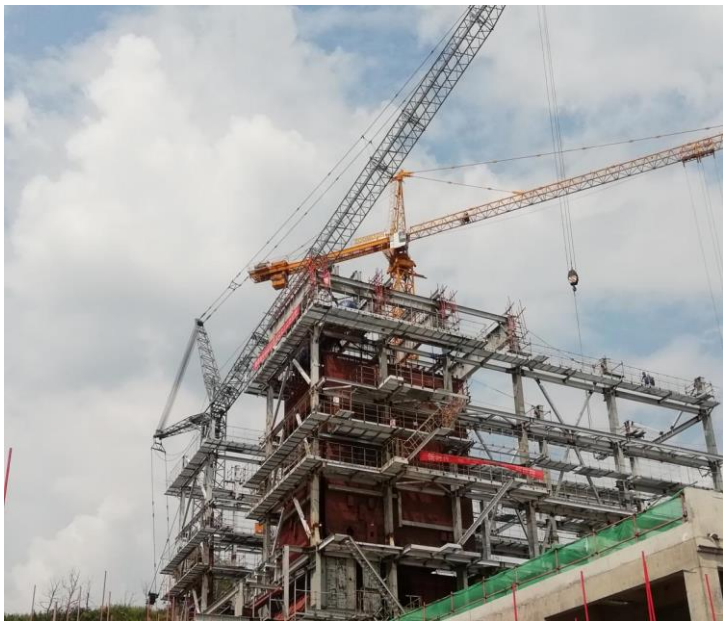
#1、#2 焚燒爐鋼架吊裝施工
