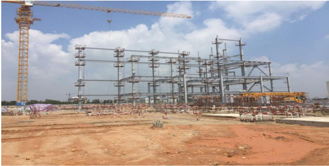
#1 主廠房鋼結構吊裝
