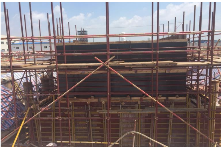
#1 燃機基礎施工
