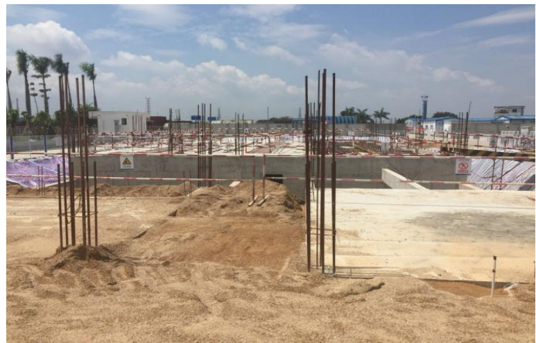
GIS 樓零米以下結構施工完成
