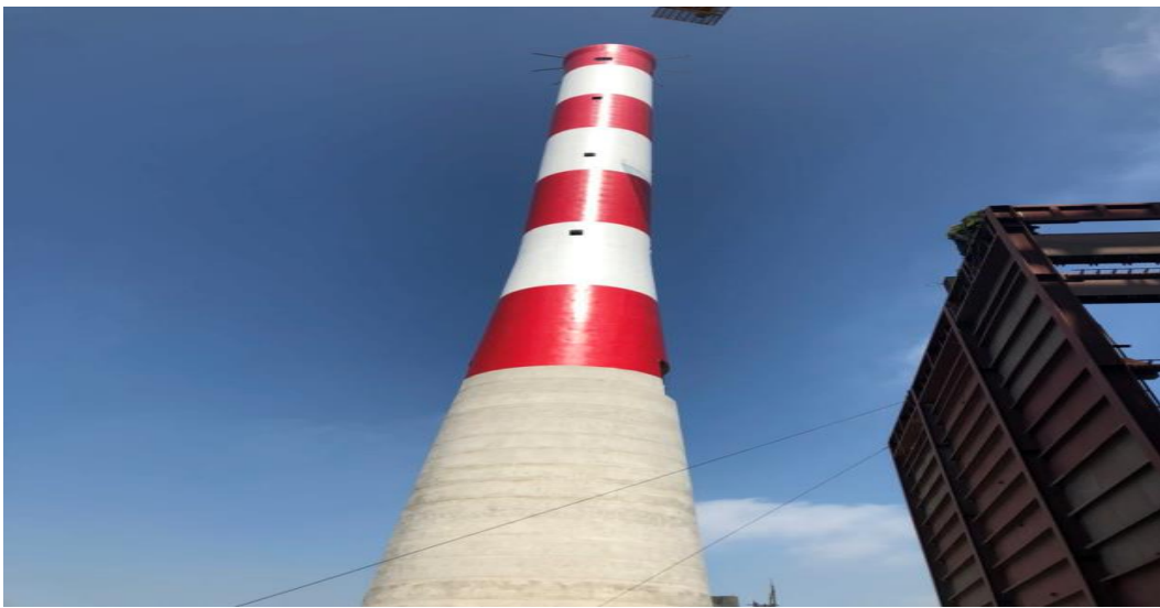
煙囪筒身澆築完成
