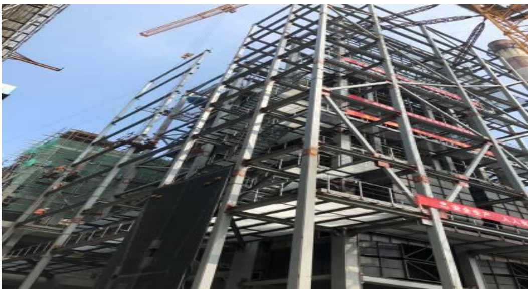
鍋爐鋼架吊裝
