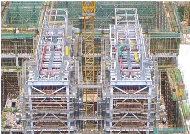
鍋爐鋼架安裝
