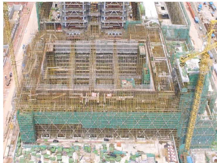
垃圾池結構施工
