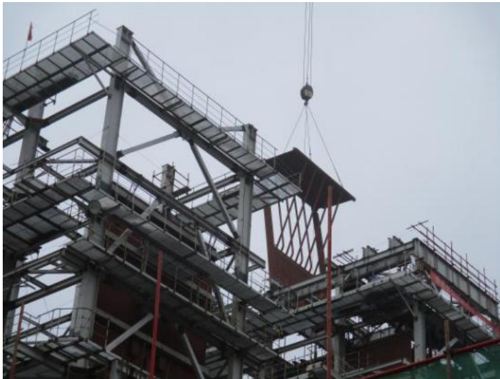
#1、#2 焚燒爐鋼架吊裝施工
