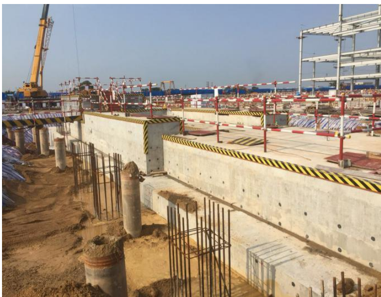
#1 燃機基礎施工
