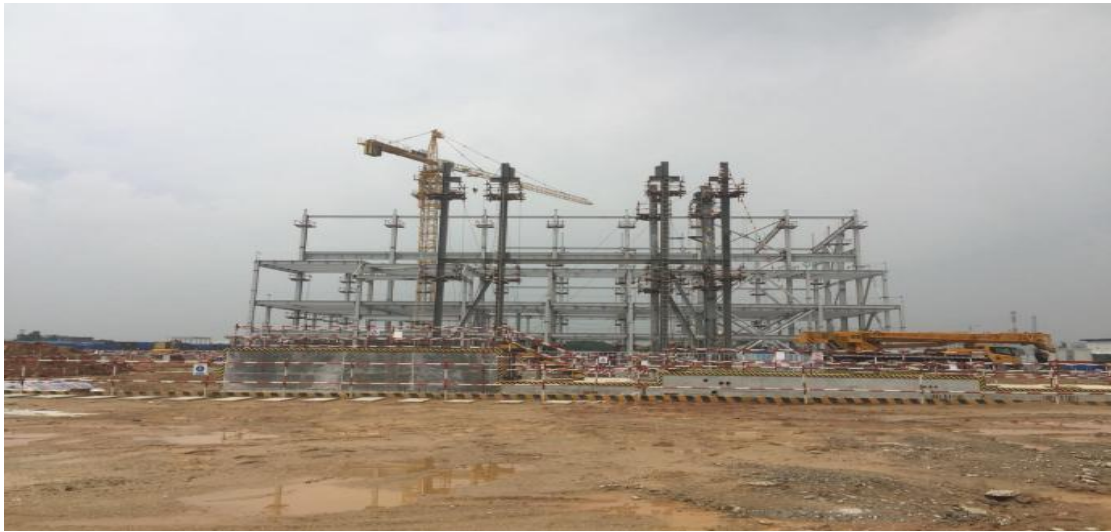
#1 主廠房鋼結構吊裝
