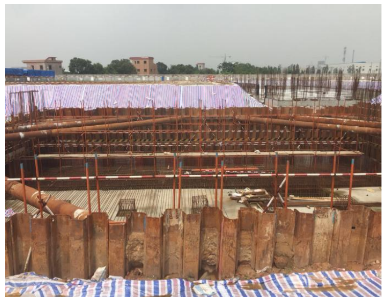
迴圈水泵房地下結構施工完成
