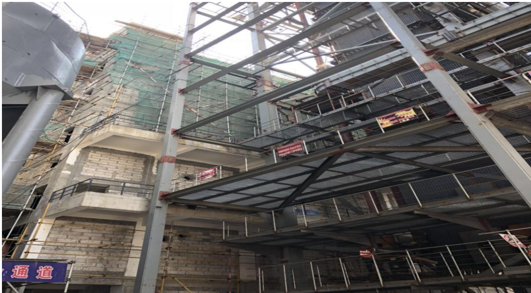
主廠房砌體施工
