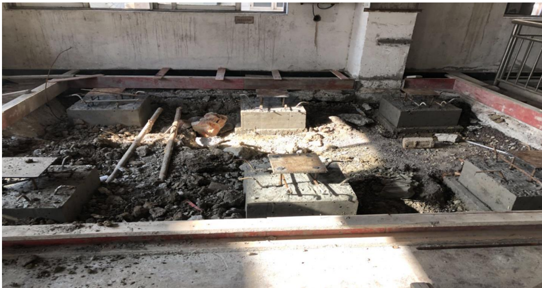
汽機房輔機設備基礎施工
