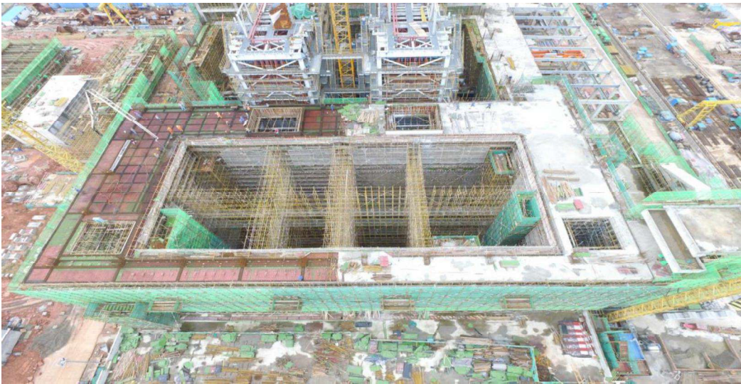
垃圾池結構施工
