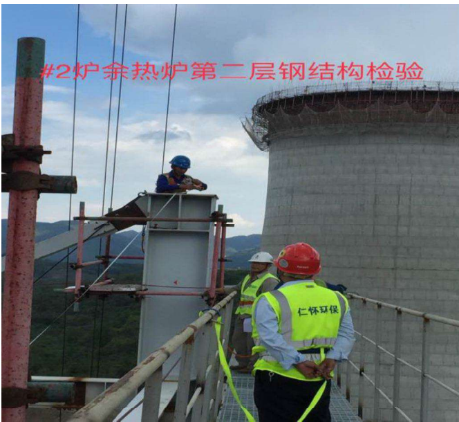
#2 餘熱爐第二層鋼結構檢驗
